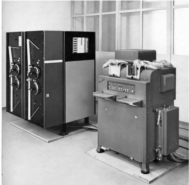
Figure 7. Conversion of paper tape to punched cards at SKA. (Source: Technische und organisatorische Fortschritte im Dienste unserer Kunden , p. 25, SKA, 1963. Copyright: Credit Suisse Group, Zürich.)
